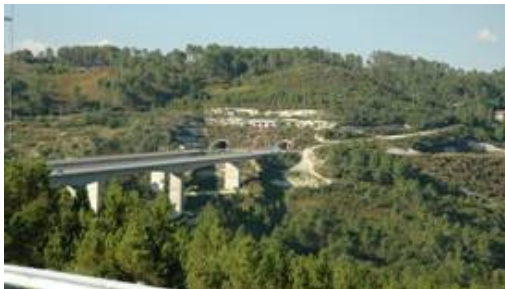
[Viaduto na A24 – Tunel de Castro d’Aire]
